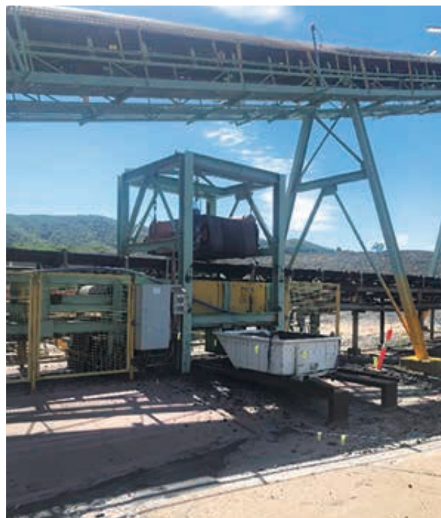
兗煤澳洲洗煤廠原煤入洗系統
