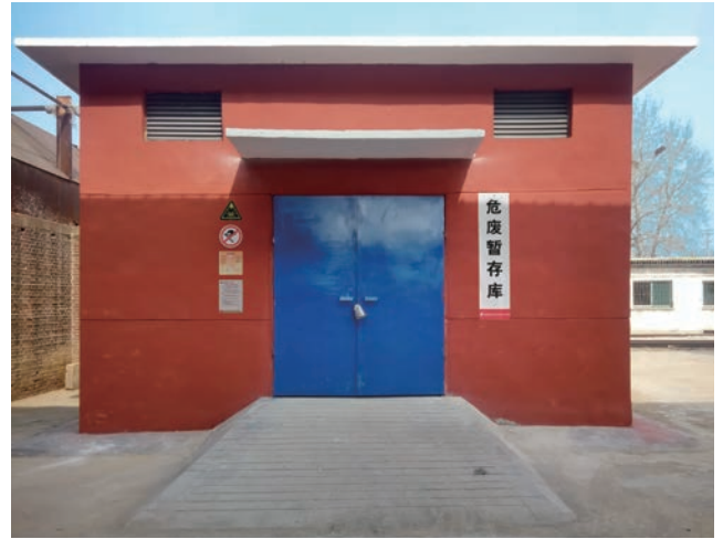
危險廢物儲存庫
