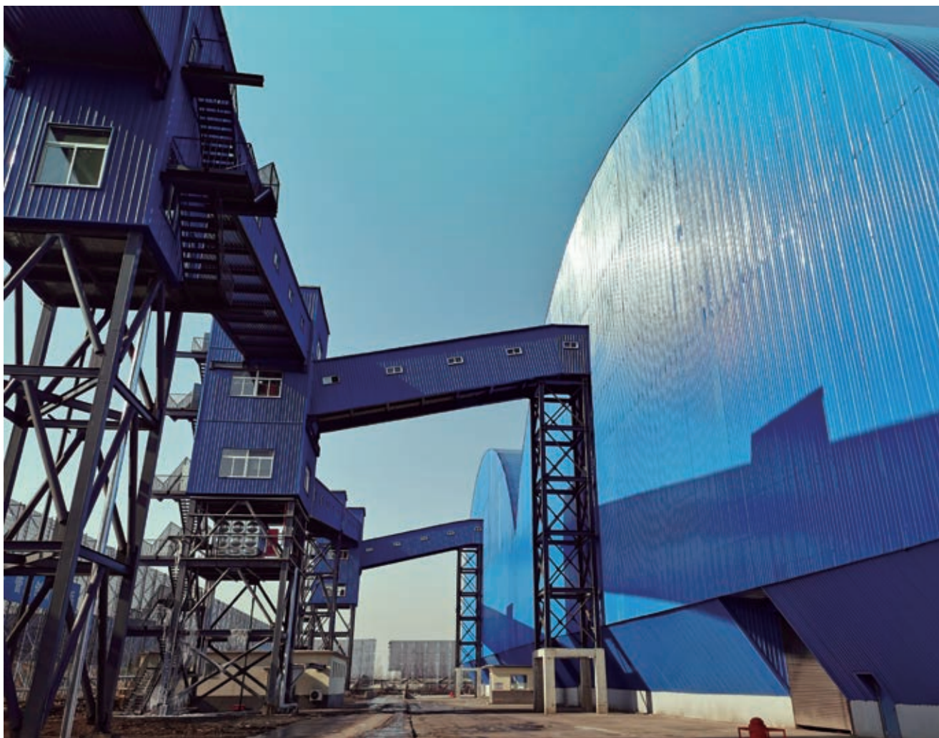
鲍店煤矿储煤基地
